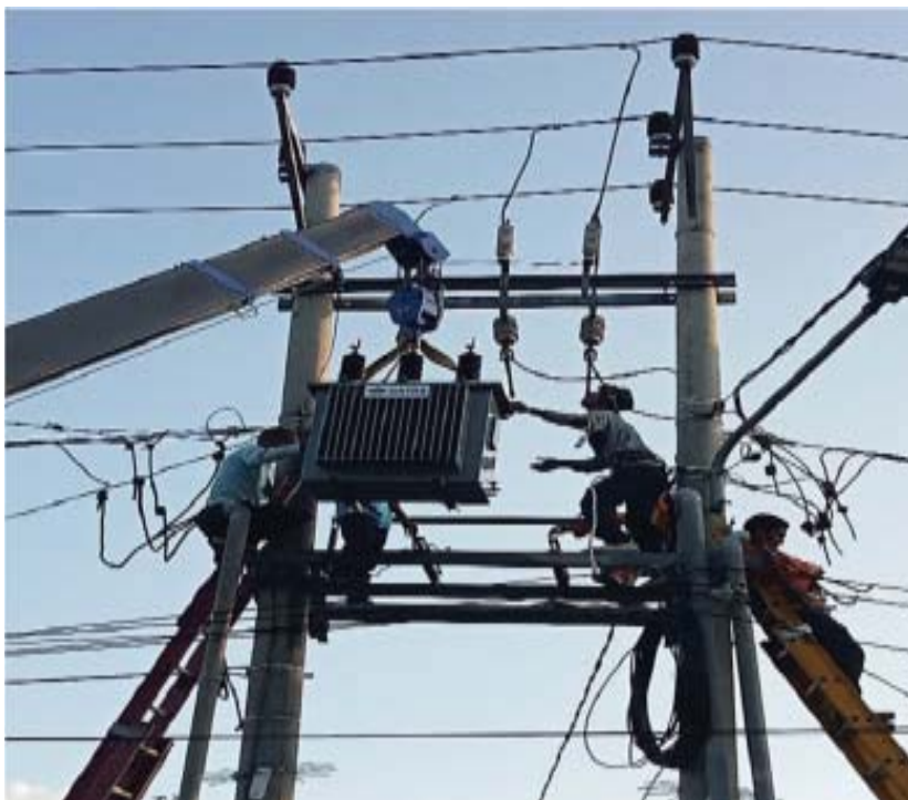
Manutenção da linha de transmissão de média tensão
