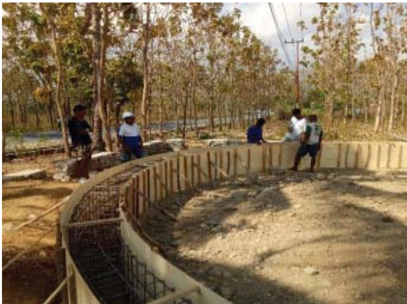
Construção de um tanque reservatório
